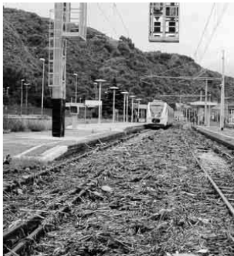
LA STAZIONE FERROVIARIA DI GIAMPILIERI DOPO LA TERRIBILE ALLUVIONE DEL 1° OTTOBRE
